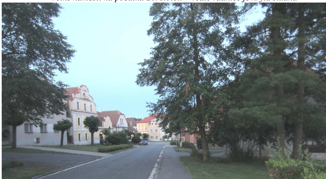
Stejný pohled o 100 let později – z tohoto úhlu dnes starou radnici zakrývají stromy – studna je již jen pod betonovým poklopem
