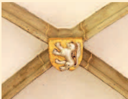
Erby na svornících v kaplích sezemického kostela
