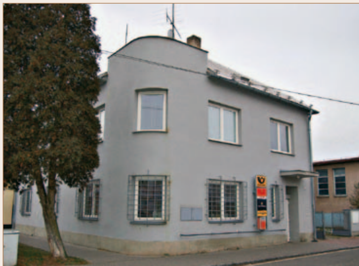
Již řadu desetiletí je sídlem pošty dům čp. 114
